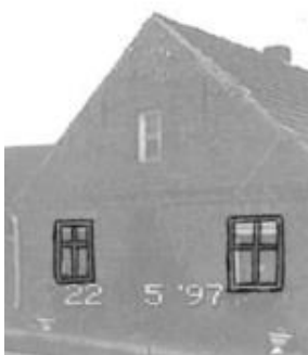
Typische Fensterteilung Langensalzwedel. Quelle: Dorferneuerungsplan
