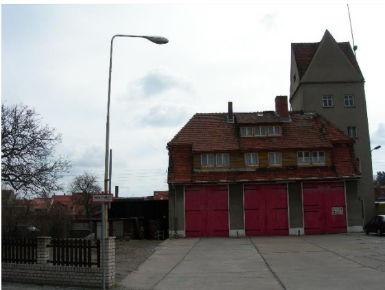
Das alte Gerätehaus
