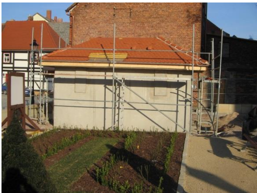
Neubau der WC-Anlage an der St. Stephanskirche
