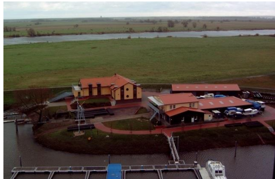
Vereinsgelände von TWV u. TRC nach der Sanierung
