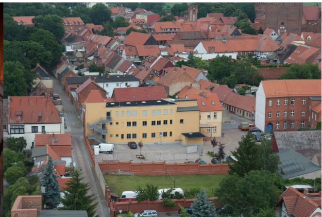
Außenaufnahme nach der Sanierung
