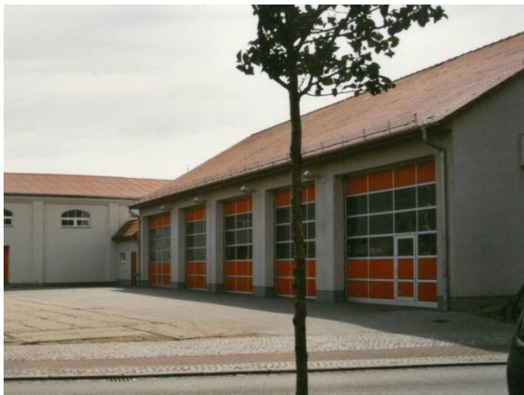
Außenanlagen Fahrzeughalle vor Neugestaltung
