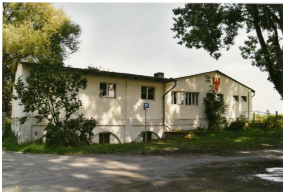
Bootshaus TRC vor der Sanierung
