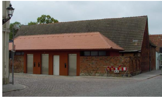
Neu errichtete WC-Anlage am Neustädter Tor
