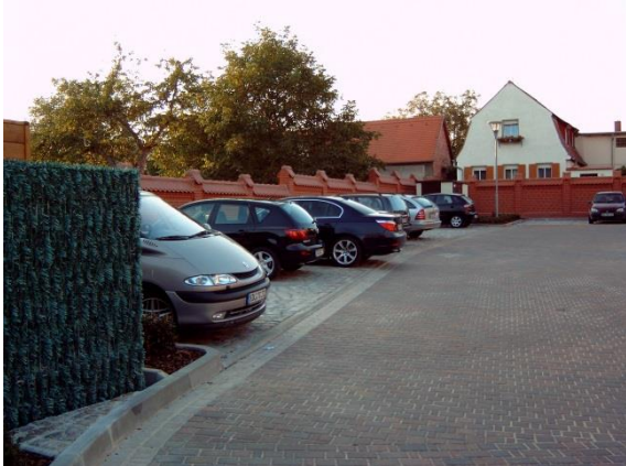
Teil des neugestalteten Stellplatzes Notpforte
