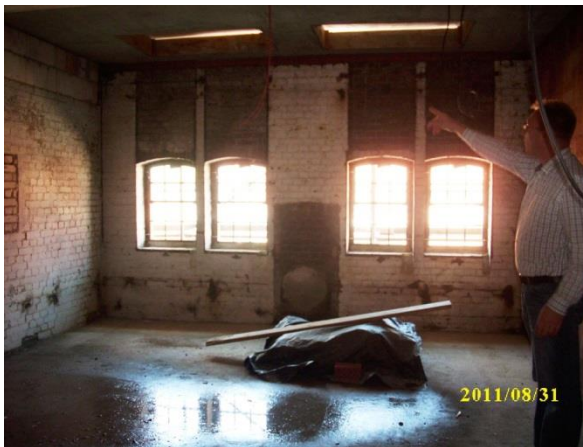
Innenaufnahme während der Sanierung
