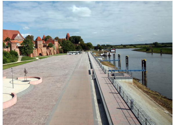
Hafenpromenade mit Spundwand nach Neugestaltung
