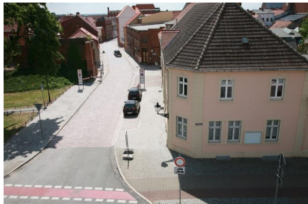
Notpforte nach Durchführung der Maßnahme
