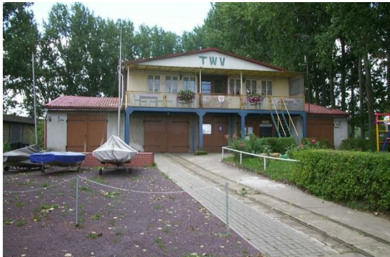
Bootshaus TWV vor der Sanierung
