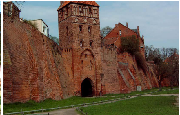
Stadtmauer mit Roßfurt nach Sanierung
