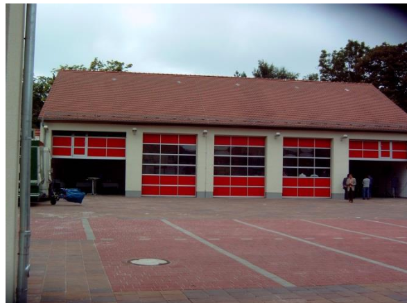
Außenanlagen Fahrzeughalle nach Neugestaltung
