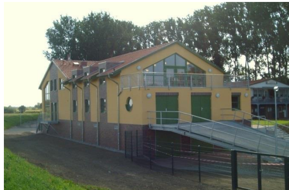
Bootshaus TRC nach der Sanierung
