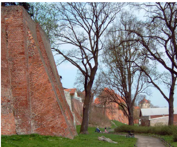
Stadtmauer und Außenanlagen vor Sanierung
