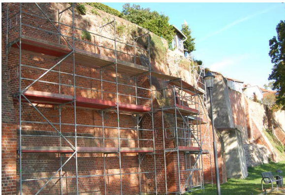
Stadtmauer während Sanierung
